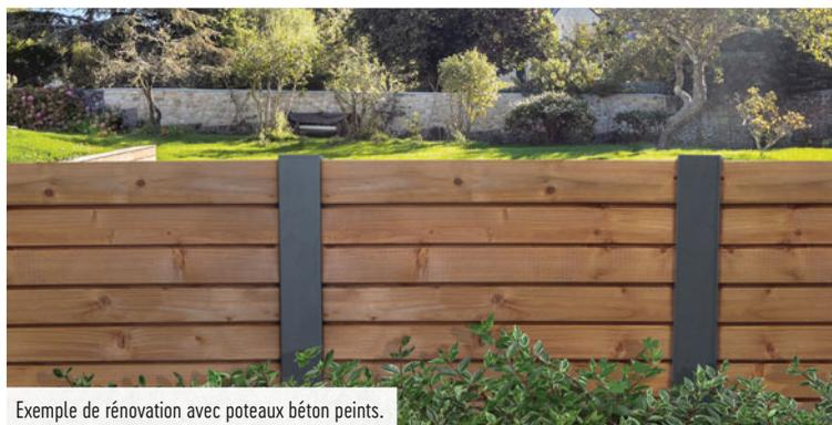
Exemple de rénovation avec poteaux béton peints.
